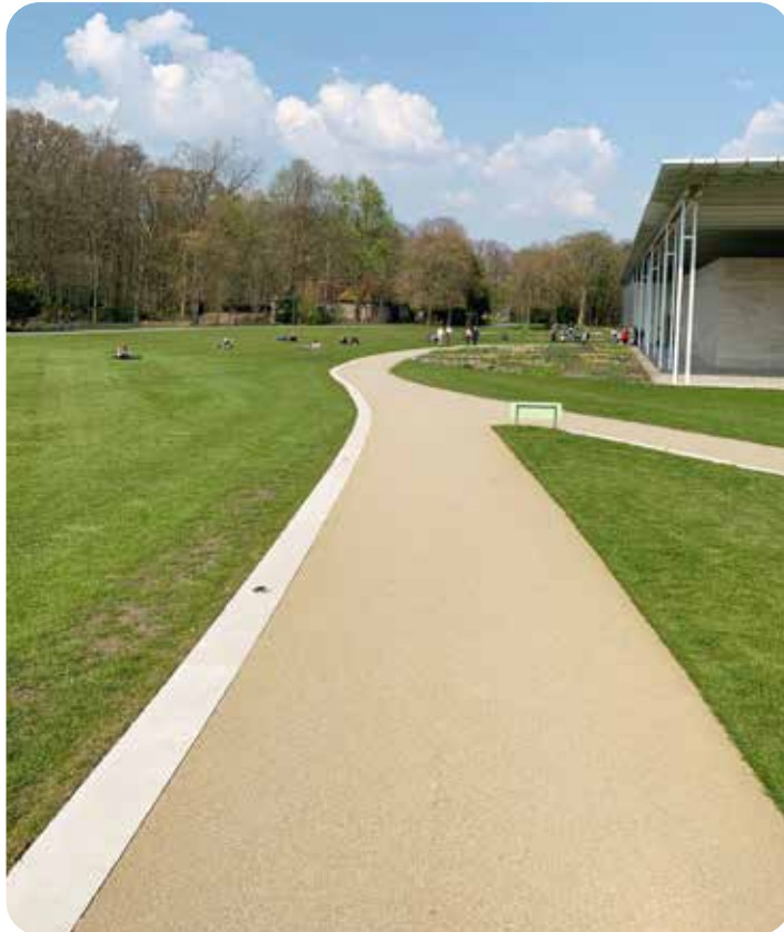
Gele stabilizer of asfalt (met betonnen rand)
