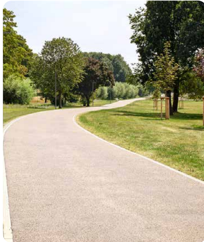
Gele stabilizer of asfalt (met betonnen rand)
