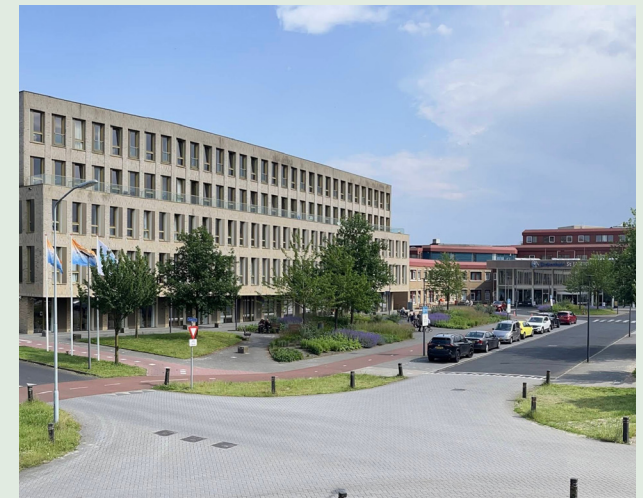
St Jansdal ziekenhuis in de centrale zone
