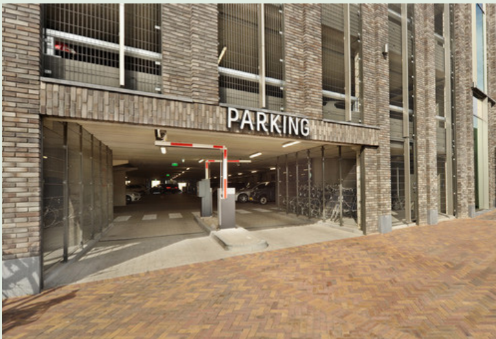
Referentie van een natuurlijk geventileerde parkeergarage v.v. metselwerk.
