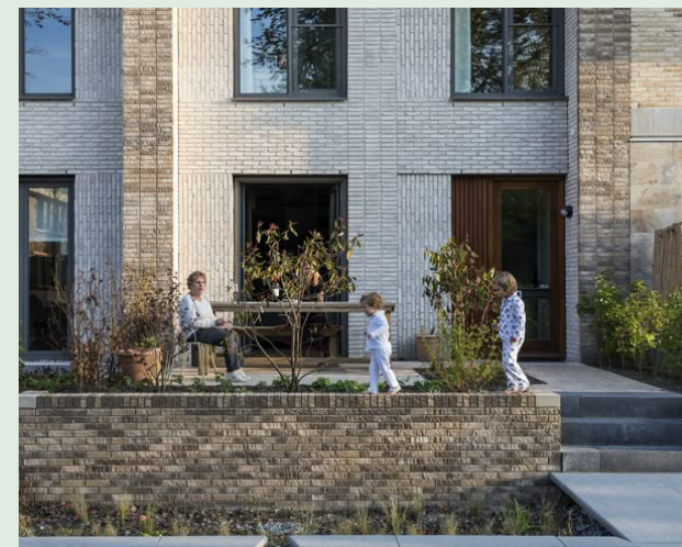
Ontwerp terrassen mee met de woning door gebruik van dezelfde soort gevelsteen
