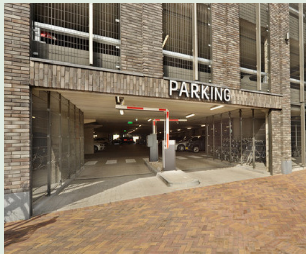
Referentie van de meerlaagse parkeergarage in blok C
